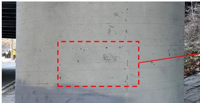
Fig. 2 a) Pier S-10
